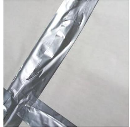
(圖十一)貼合丁基橡膠防水膠帶後，即可覆蓋遮雨棚上蓋金屬板，因此藉由上蓋金屬板可保護丁基橡膠不直接曝曬在 UV 光下，增加其耐用壽命；而丁基橡膠的耐高溫不易垂流特性，亦可補足上蓋金屬板因熱漲冷縮作用產生的各處細縫而易漏水的窘境，並可長期持續發揮優異的防水效果。
