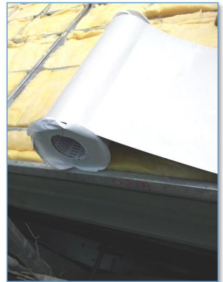
(圖三)將已貼合丁基橡膠 No.5032-450mm 防水膠帶，以刀片小心割除撕除白色離型紙約 20mm，露出黑色丁基橡膠。
