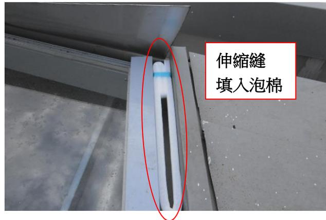
伸縮縫處黏貼丁基橡膠 NO.412 鋁箔防水膠帶
