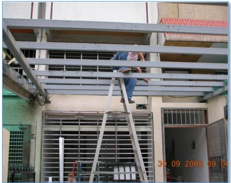
在左邊浪板搭接處貼上丁基橡膠 No.503 系列防水雙面膠帶，把右邊另一片浪板搭接上，壓合後鎖上螺絲固定即可。
