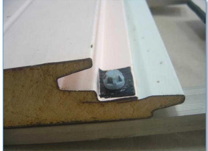
在彩色鋼板搭接處貼上丁基橡膠 No.503 系列防水雙面膠帶，再搭接另一片彩色鋼板即可防水氣密。
