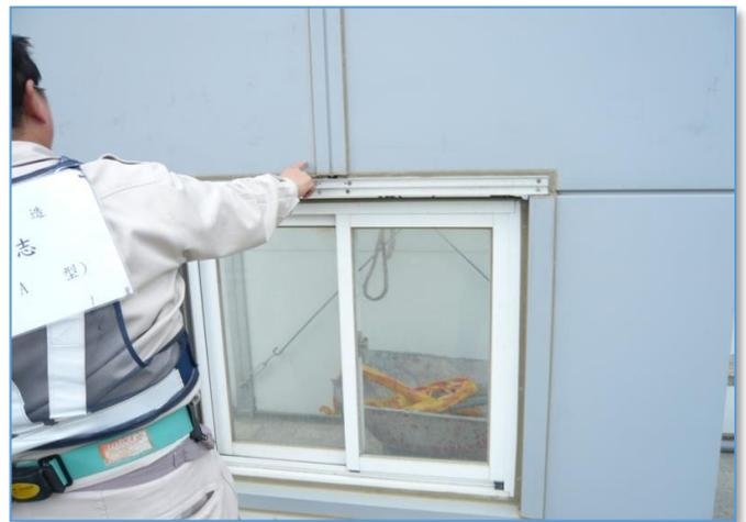
在螺絲孔上貼上丁基橡膠 No.503 系列防水雙面膠帶，鎖上螺絲時，會順道把丁基橡膠旋轉帶入即可防水氣密。
