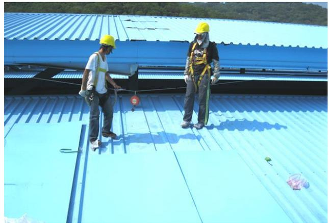
下圖:在彩鋼浪板上貼上丁基橡膠 No.503 系列防水雙面膠帶，再搭接其它片彩鋼浪板。
